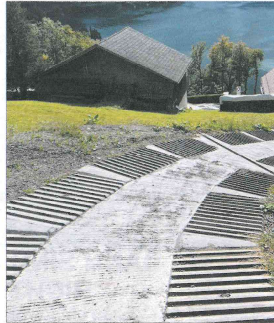
Die Notsanierung im Abschnitt Wilenstrasse bis Station Mitterschwanden abgeschlossen.
